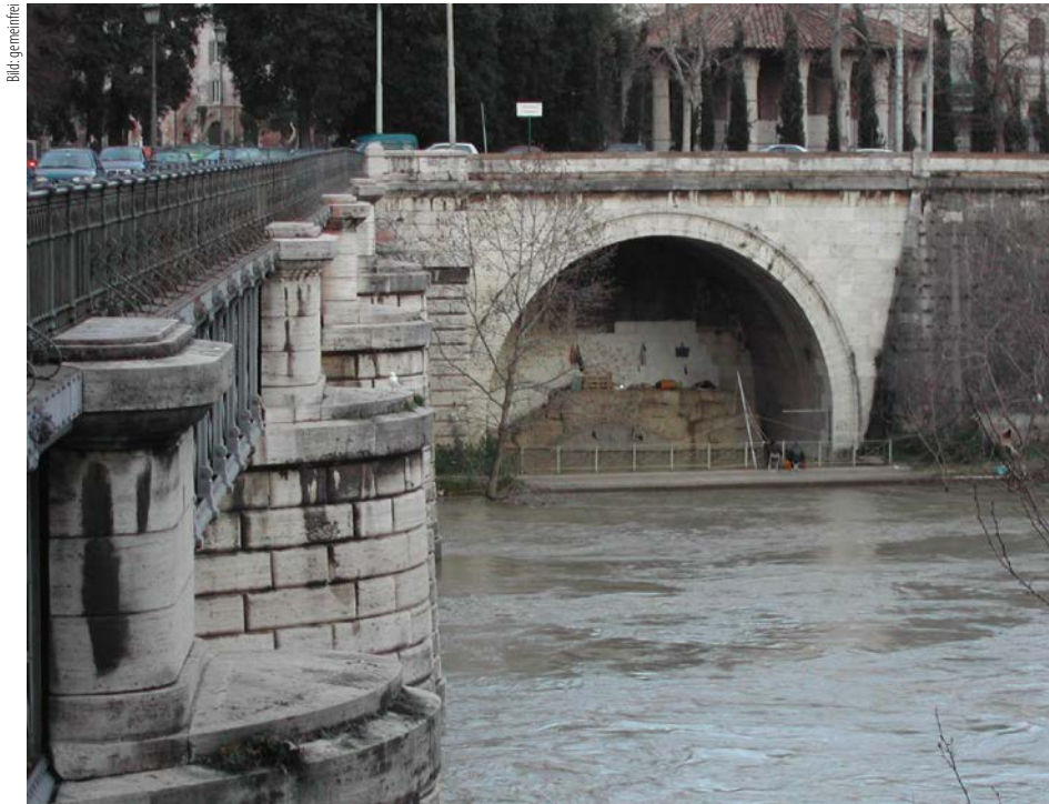
Die «Cloaca Maxima» ist Teil eines antiken Kanalsystems in Rom, das auch heute noch funktionstüchtig ist. Tarquinius Priscus, fünfter König von Rom, soll das umfangreiche Kanalsystem zur Entwässerung der Senke zwischen Palatin und Kapitol, dem späteren Forum Romanum, geschaffen haben.
